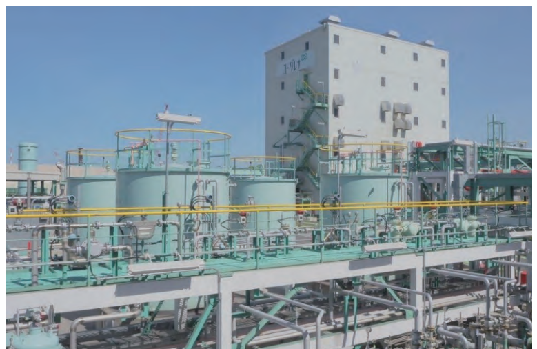
バイオ燃料実証製造プラント
